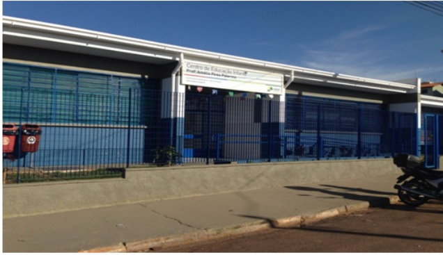
Figura 2 - Fachada do CEI
