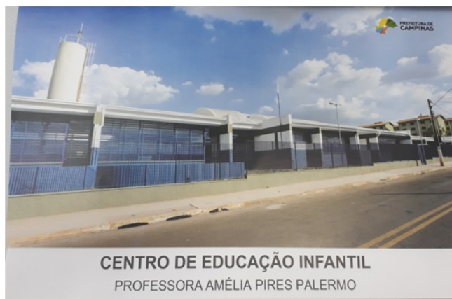
Figura 1 - Fachada do CEI
